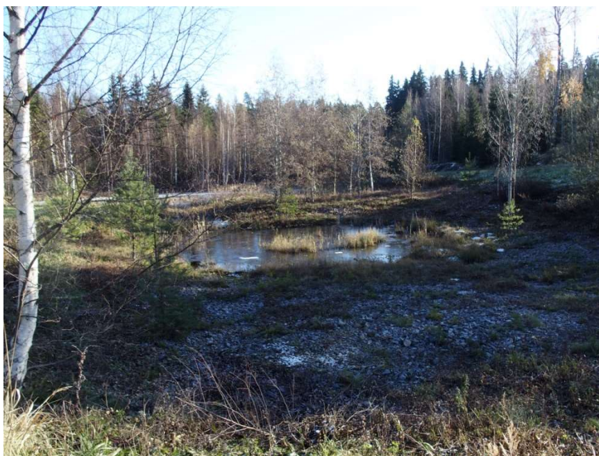
Kuva 18. Esimerkki hulevesialtaista Tampereelta. Mäyränmäen asuinalueen hulevesien hallintaa varten on toteutettu kolmen peräkkäisen altaan järjestelmä. Ensimmäisessä altaassa ei ole pysyvää vesipintaa. Kuvassa etualalla näkyvän keskimmäisen altaan pysyvän vesipinta-alan suuruus on noin 150 m 2 ja kuvassa takana näkyvän viimeisen altaan pysyvän vesipinta-alan suuruus on noin 800 m 2 . Altaisiin on muodostunut luontaista kosteikkokasvillisuutta. Kuva © Destia Oy 2024.
