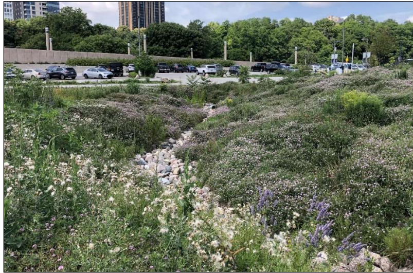
Kuva 15. Esimerkki luonnonmukaisesti muotoillusta avouomasta, johon on toteutettu eroosiosuojaus. Milwaukee, Wisconsin. Kuva © Aaron Walkening CC BY 2.0.
