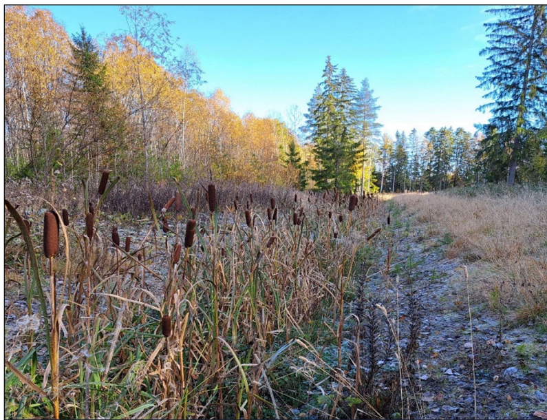
Kuva 16. Esimerkki tulvauomasta Järvenpäästä, kuvaussuunnassa on iso teollisuusalueen hulevesien viivytysallas. Uomaan on toteutettu pohjapato ennen purkua hulevesialtaaseen ja uoman luiskien eroosiosuojaus on toteutettu pienlouheella. Uoman pohjalla oleva kasvillisuus hidastaa veden virtausta. Kuva © Destia Oy 2024.
