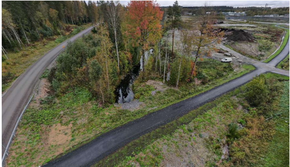
Kuva 10. Suunnittelualueen eteläreunalla sijaitseva Häijääntien ja jalankulku- ja pyöräilyväylän alittava rumpu, jonka kautta pintavesiä virtaa suunnittelualueelle etelän suunnasta. Kuva © Destia Oy 10/2023.
